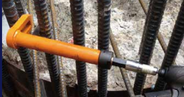
杭頭筋へベース筋を通す作業に
