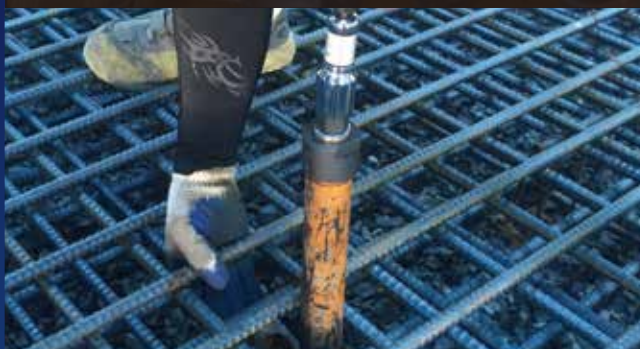
スペーサー手直し時のスラブ持ち上げ作業
