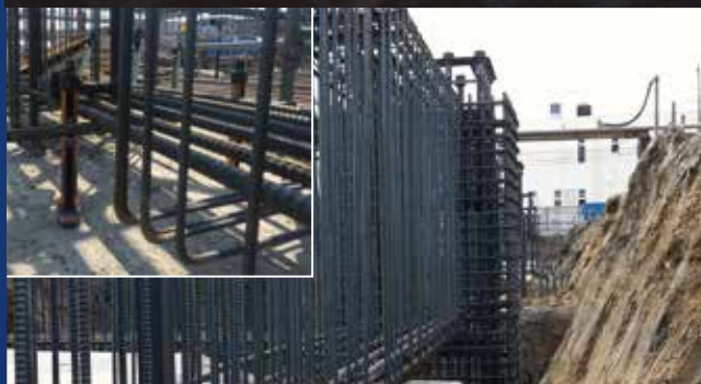
スタラップ配筋時の下筋の持ち上げに
