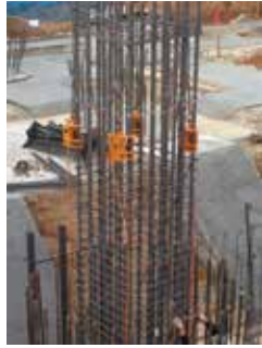
・柱吊用天秤とクランプを使用して 柱筋を安全確実に移動できます。
