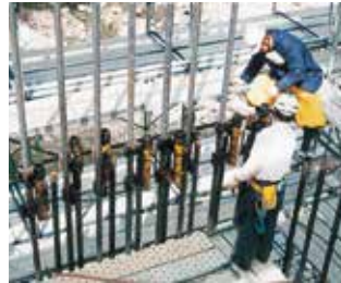
・クランプに噛み込んだ鉄筋4本を確実に移動できます。
