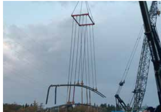
・クランプに噛み込んだ鉄筋4本を確実に移動できます。
