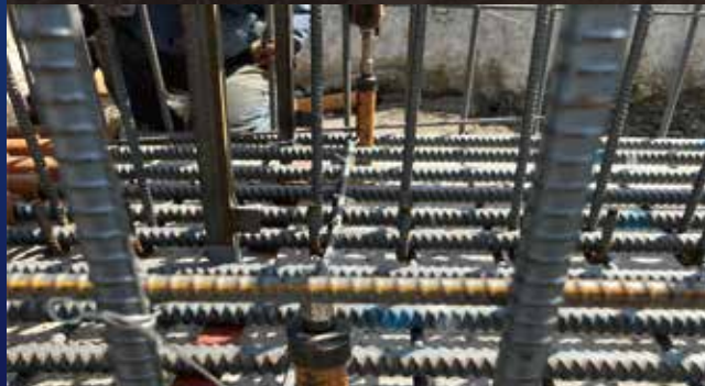
ネジ筋のカブラセット時の高さ調整に
